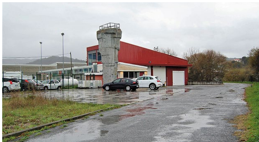
■ Actuais instalacións do parque comarcal de bombeiros
